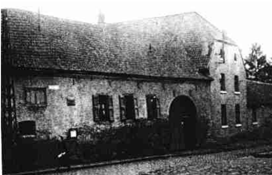
Abbildung aus 'Baesweiler in alten
