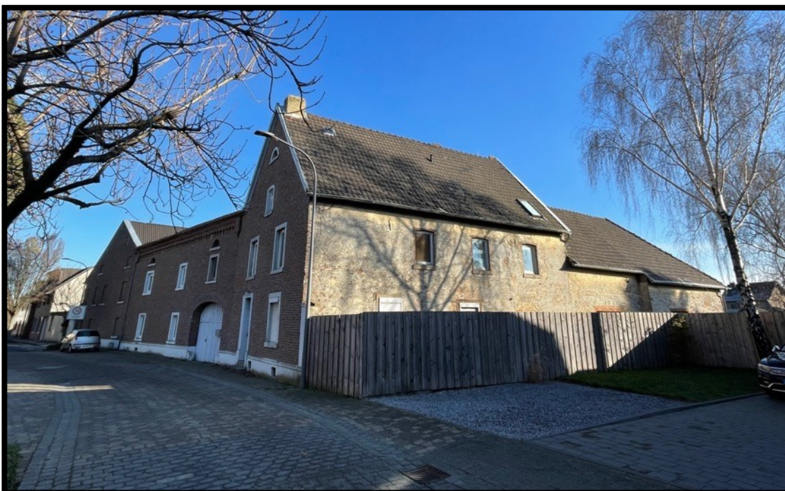
Abb. 7: Ansicht auf die Nord- und Westfassade der alten Brauerei von der Lindenstraße aus.
