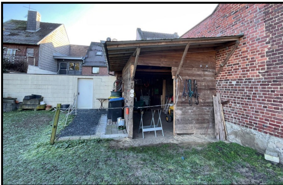
Abb. 12: Offener Geräteschuppen im Süden der Planfläche.
