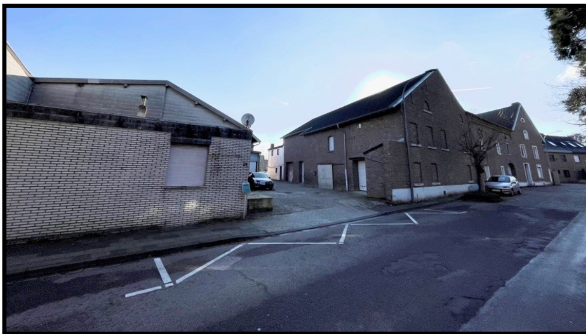
Abb. 8: Blick von Osten auf die alte Hofanlage, rechts, und die vorgelagerten Anbauten aus den 1970ern links im Bild.
