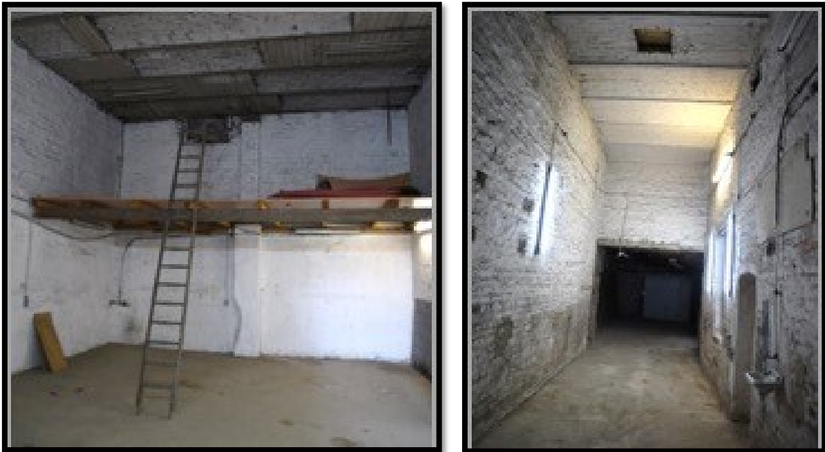
Abb. 18/19: Blick in das Gebäude 11
